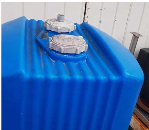
Täyttöaukot säiliön päällä.
